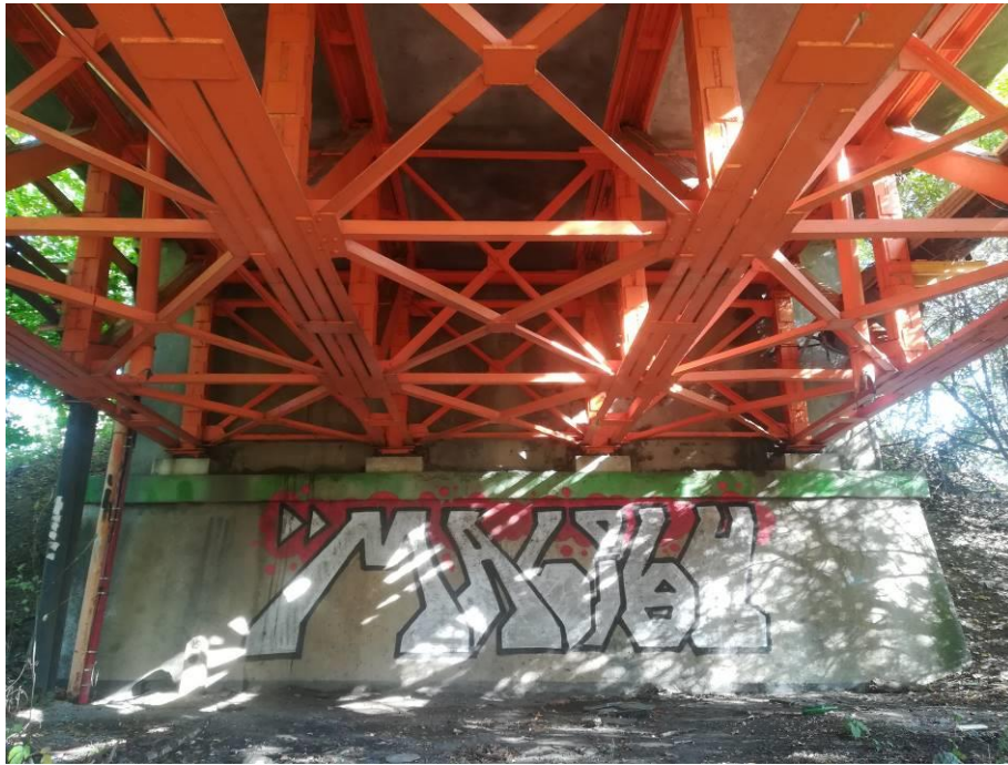
Fot. 2. Widok podpory skrajnej obiektu i konstrukcji kratownicy stalowej pomostu.
