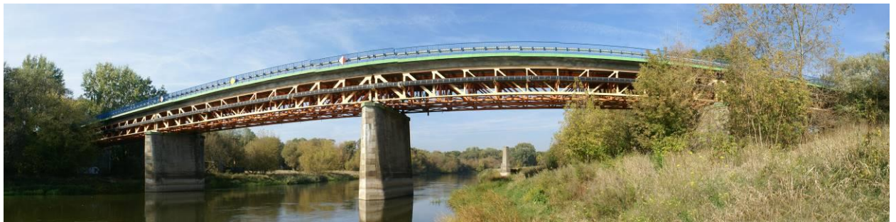
Fot. 3. Widok z boku obiektu (przęsła i podpory nurtowe).
